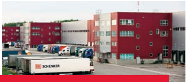
Логистический комплекс «Логопарк Север», Московская область Плоская кровля
