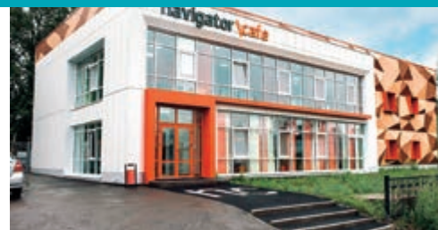
Роботехнопарк «Навигатор Кампус», Казань Вентилируемый фасад
